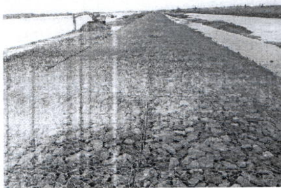
Thi công nạo vét kênh và thâm đá Công trình luồng cho tàu biển tải trọng lớn vào Sông Hậu
